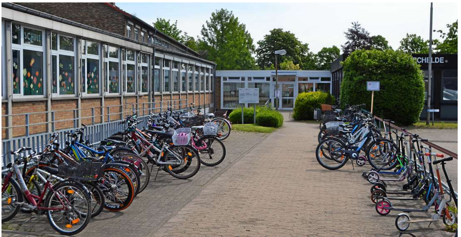
Aus allen Nähten platzt die Grundschule Vechelde.
